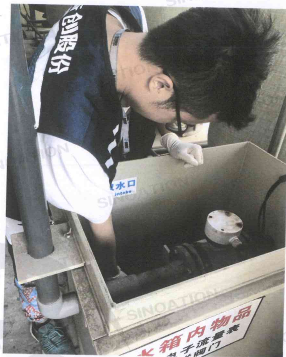
车间废水排放口
