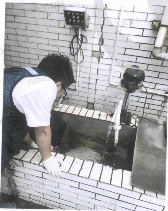
生产废水总排放口
